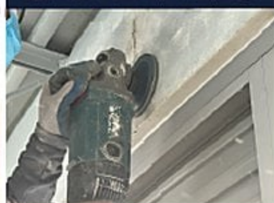
REMOCIÓN DE PINTURA
